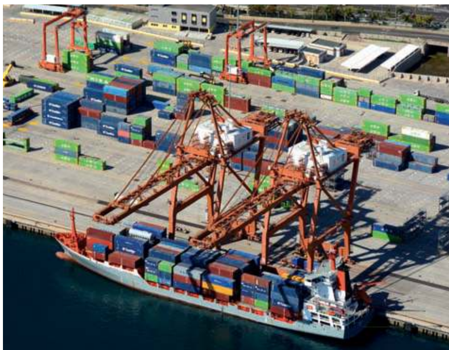
> Terminal de Contenedores de Tenerife (TCT) que inició su actividad en abril de 2013. La concesión, con una extensión de 13 hectáreas y operada por el Grupo OHL y Marina Davila, tendrá capacidad para mover 575.000 TEUs con una línea de atraque de 700 metros.
