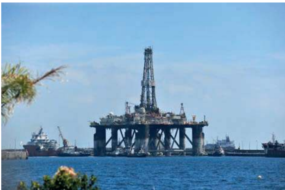
> La reparación y mantenimiento de grandes plataformas para la exploración y explotación del petróleo offshore, que trabajan en el Golfo de Guinea, se perfila como una interesante actividad para el puerto de Santa Cruz de Tenerife. En la foto, plataforma de Transocean atracada en el Dique del Este en marzo de 2014.
