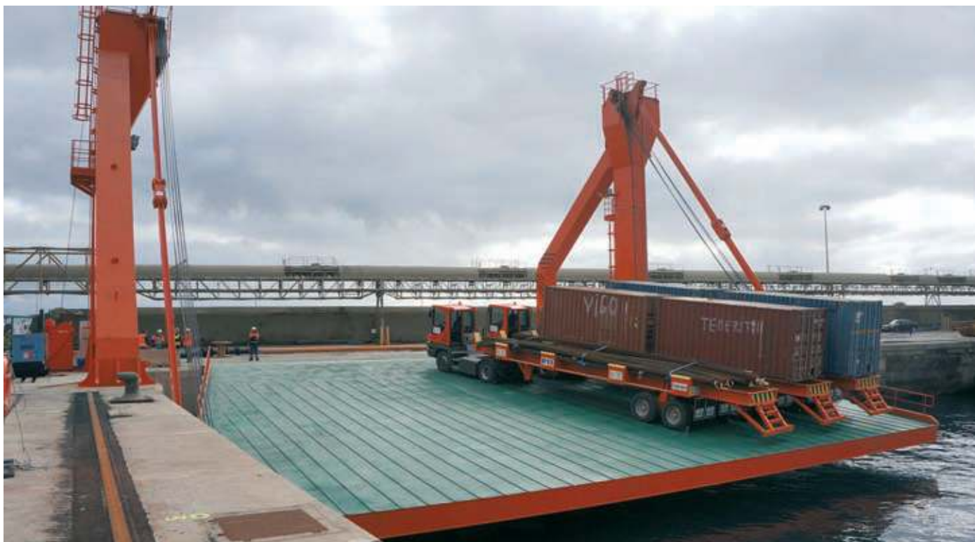
> La rampa Ro-ro instalada por TCT en sus nuevas instalaciones de Santa Cruz de Tenerife es única en España. Sin necesidad de aumentar la longitud de atraque mediante una rampa convencional, el sistema soporta el peso de cuatro camiones cargados sobre la plataforma de 25x20 metros accionada eléctricamente y fabricada por Zamakona.
