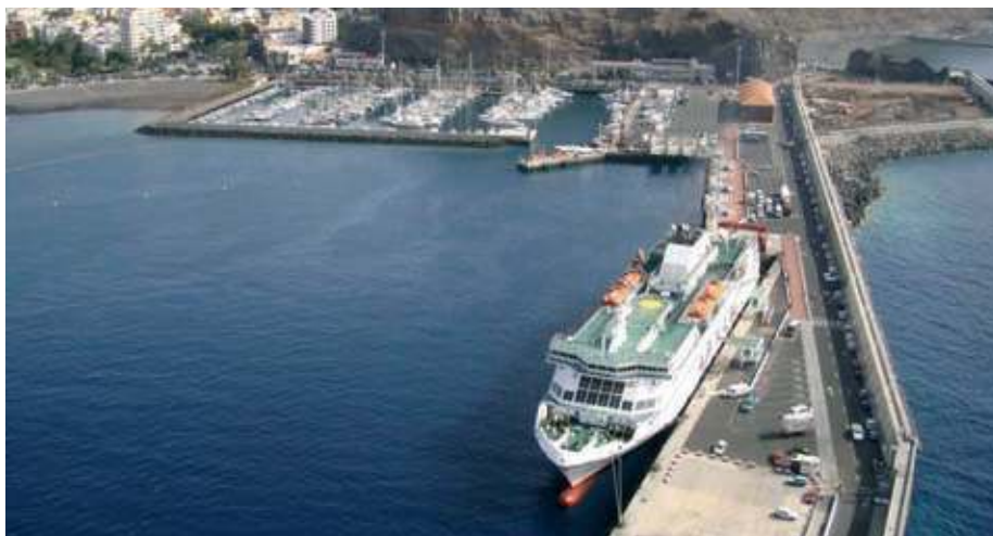
> El puerto de San Sebastián de La Gomera ampliará su dique exterior para atender con más ventaja el tráfico de cruceros.
