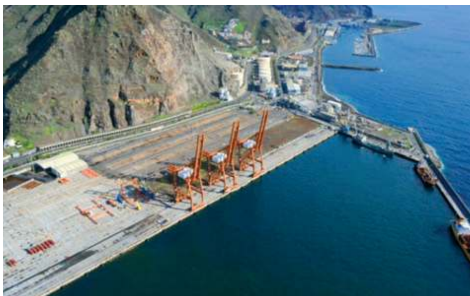
> Las tres grúas Super Post Panamax de la primera fase instaladas en la nueva Terminal de Contenedores de Tenerife (TCT).
